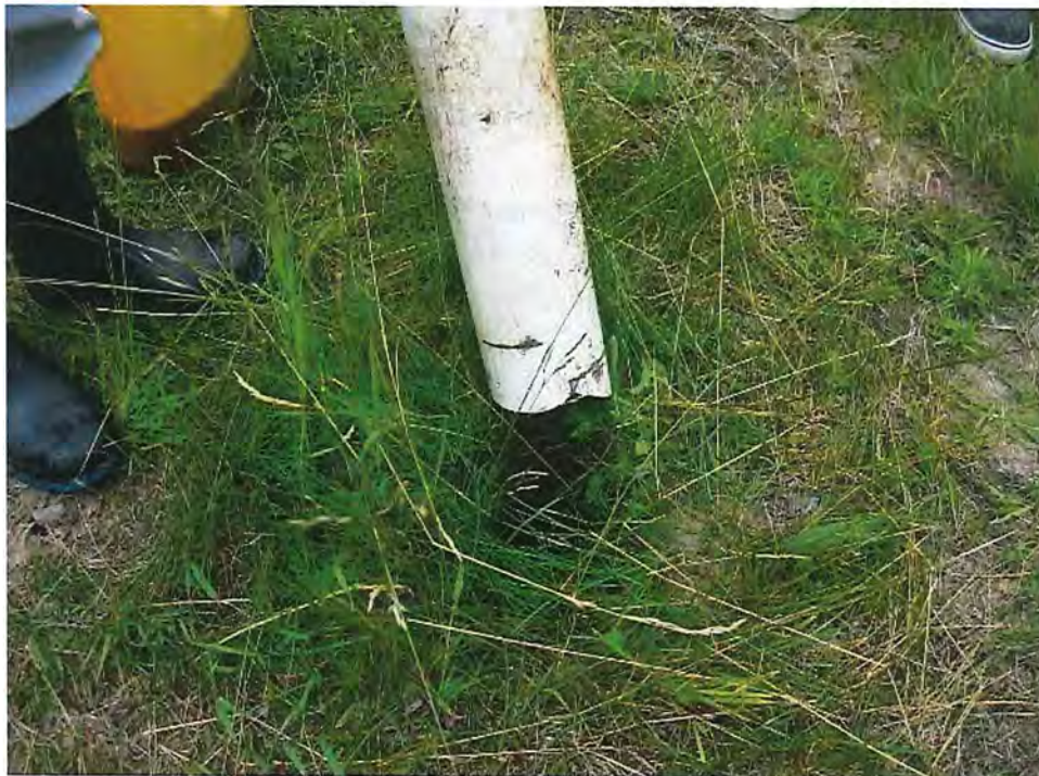
Photo 8 Installation septique 1 – piézomètre 1 s'enlevant facilement
