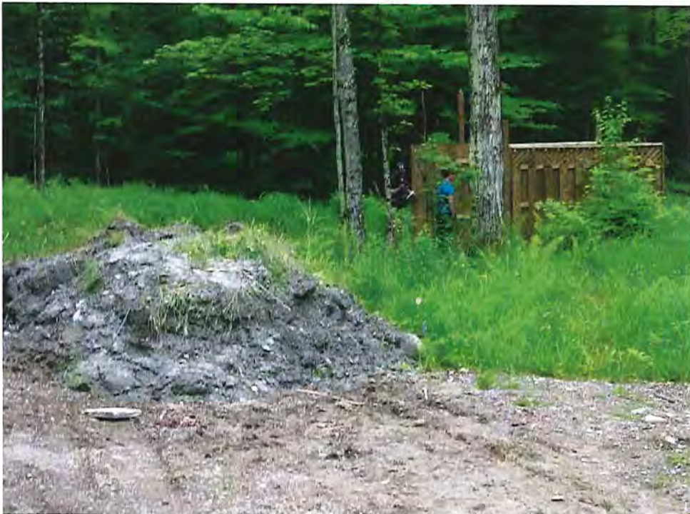
Photo 15 – Station de pompage 1A située au sud du site 517
