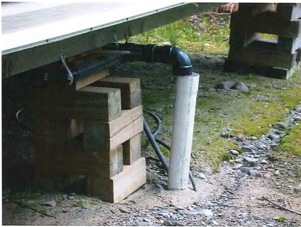
Photo 35 chalets sites 651 à 658 placés sur des blocs et en attente d'être raccordés
