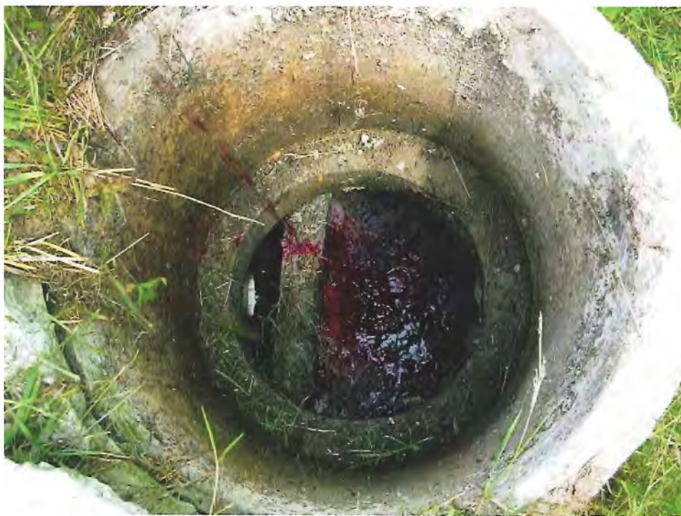
Photo 23 fosse septique de la salle communautaire – colorant pourpre
