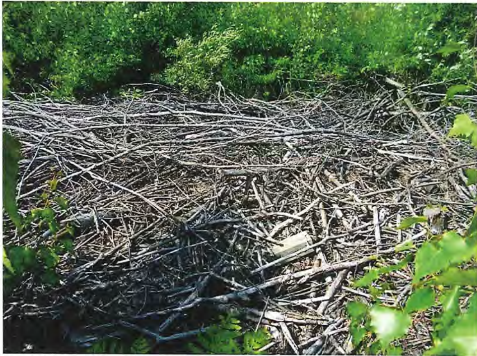
Photo 32 importante quantité de branches coupées dans le fossé nord de la rue Santiago de Cuba
