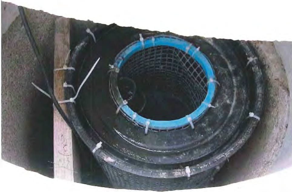
Photo 28 Installation septique 2 – troisième compartiment de la fosse septique muni d'un système artisanal
