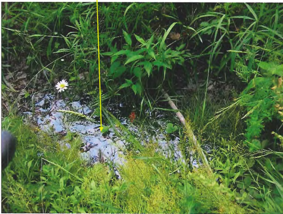
Photo 11 Installation septique 1 – échantillon prélevé à la résurgence du champ 1
